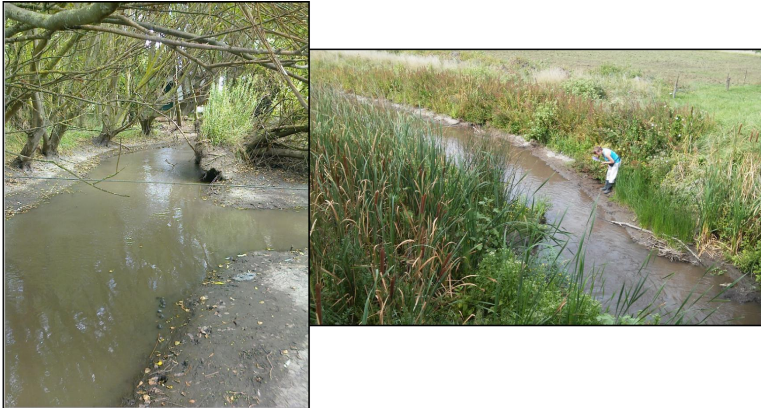
Fig. 38. Fotografías panorámica del arroyo La Carolina.
